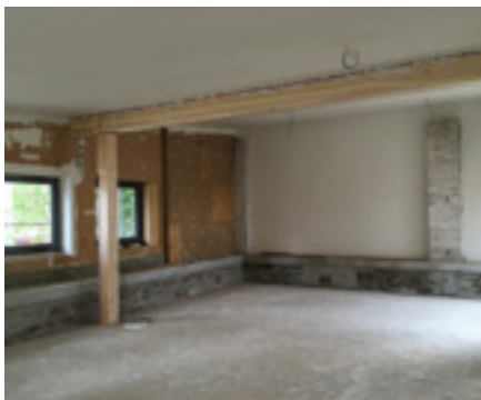
UdiSUN® im Deckenbereich verspachtelt
