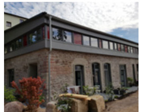
Außenansicht nach Fertigstellung
